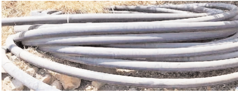
ఎదుర్కొంటున్నారా. ఇప్పటికైనా సంబంధిత అధికారులు స్పందించి పనులను వేగవంతం చేసి, పైపులను సక్రమంగా ఏర్పాటు చేసి ప్రజలకు తగునీటి సదుపాయం కల్పించాలని స్థానికులు కోరుతున్నారు.
